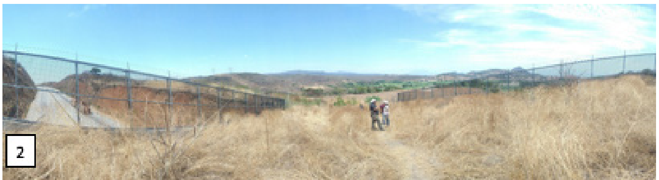
Figura 2: Localización e imagen del paso elevado sobre el macrolibramiento. 1: Mapa de la localización del macrolibramiento (imagen tomada de Google Earth). 2: Paso elevado en temporada de secas).
