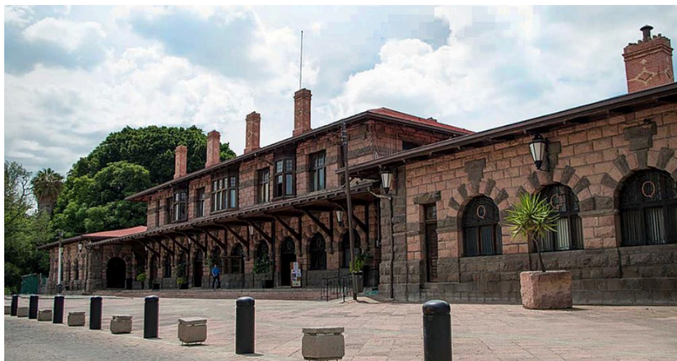
Figura 5. Estación de Querétaro en la actualidad
